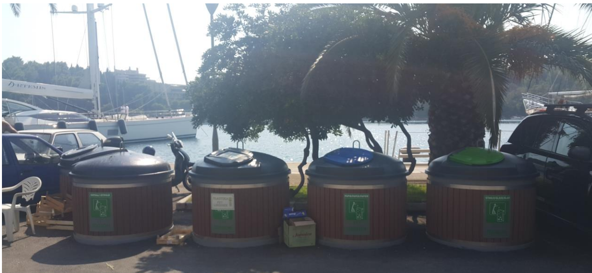
Slika 12. Sustav polupodzemnih spremnika tipa Molok u naselju Cavtat
